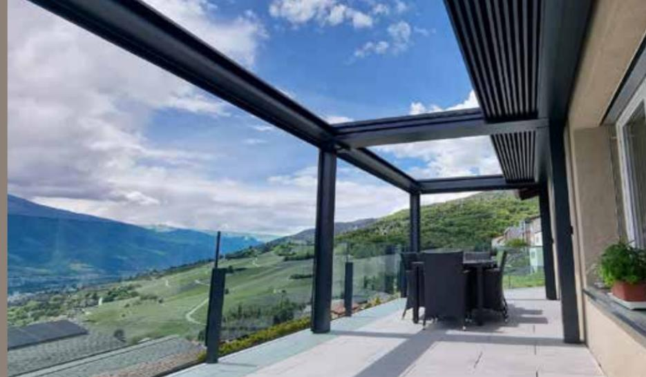
Pergola aux lames orientables et rétractables, d'un côté. Les lames s'orientent et se rétractent en réduisant considérablement l'obscurcissement de la maison en hiver.
